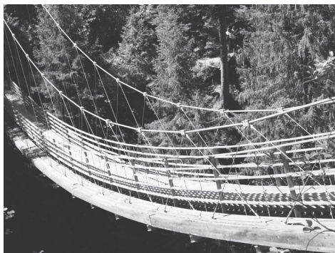
Abb. 1: «Traversinersteig» in Graubünden
